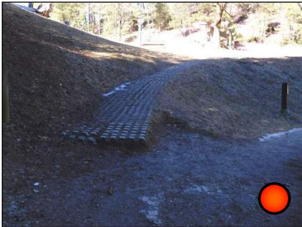
Il sentiero, ripido, che ricongiunge la riva del lago con i parcheggi soprastanti è caratterizzato, all'imbocco, da uno scalino molto alto, inoltre la pavimentazione è sconnessa e irregolare.
