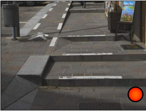
Sebbene la salita sia ripida, accanto agli scalini troviamo una rampa adibita al passaggio di carrozzine. È impossibile riuscire ad accedervi, la rampa è estremamente in pendenza.
