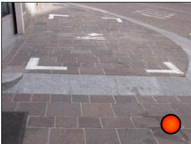
Nella parte inferiore di piazza San Giovanni troviamo una rampa eccessivamente ripida per permettere la salita di una carrozzina.
