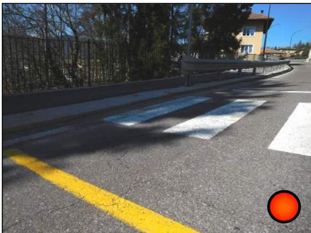
Ecco un ulteriore attraversamento ben visibile che termina a ridosso di uno scalino.
