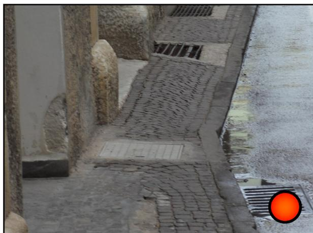
Nell'ultimo tratto il marciapiede si trasforma in camminamento, ma anch'esso è stretto per il regolare transito di una carrozzina.
