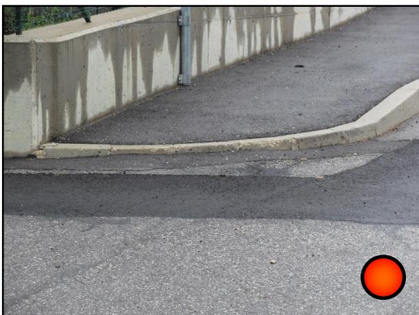
Il marciapiede anziché iniziare e terminare con una rampa si interrompe con uno scalino, difficile da superare se si è a bordo di una carrozzina.
