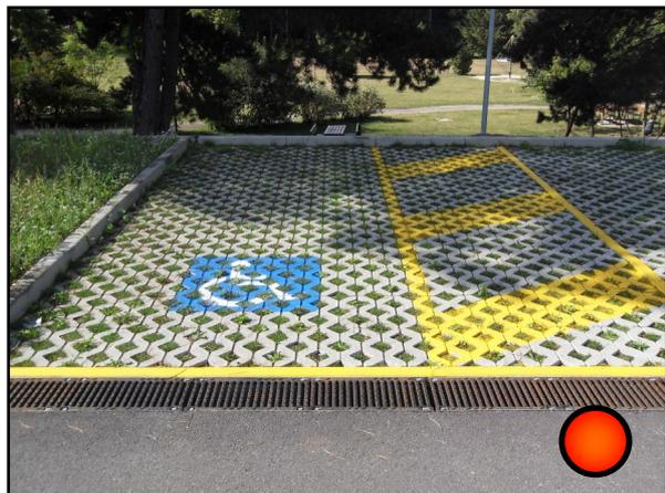
Presente parcheggio riservato a disabili, adeguatamente segnalato, nella zona limitrofa ai due laghi di Coredo, ma la pavimentazione non risulta idonea per il passaggio di carrozzine e per persone con difficoltà di deambulazione.
