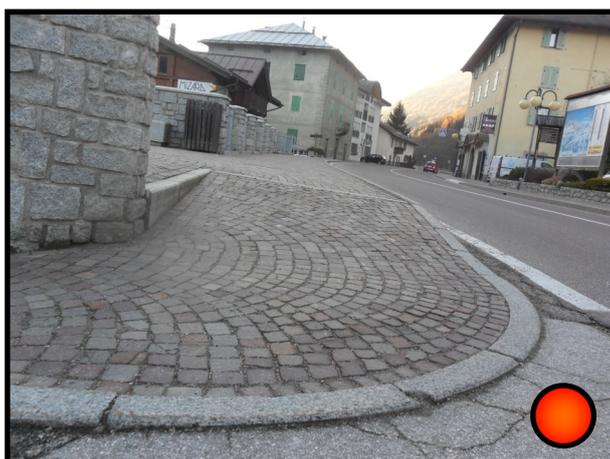
Continuando lungo la via in direzione Tonale, sulla parte sinistra della strada troviamo un inizio di marciapiede difficoltoso a causa di uno scalino di 2 cm e della piccola salita.
