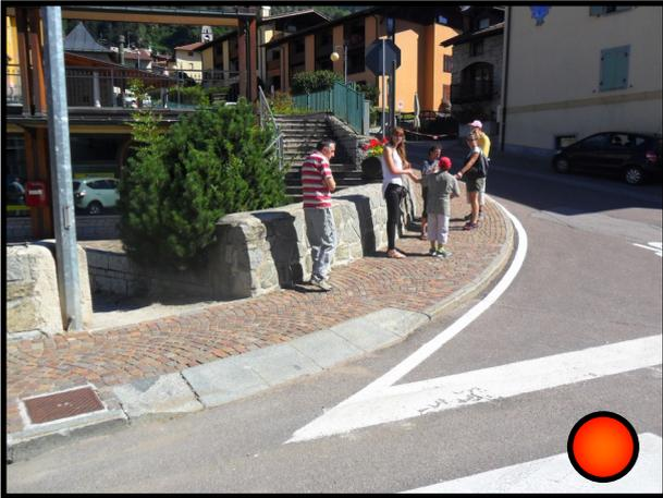
Immettendosi in via Roma, arrivando da via IV Novembre, troviamo un attraversamento pedonale in buono stato ma con una rampa con un' evidente pendenza che impedisce il transito alle persone in carrozzina.
