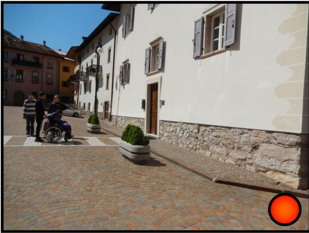
Accedere al marciapiede nei pressi della Canonica è impossibile perché non sono predisposte delle rampe e troviamo un dislivello di 8 cm. Inoltre troviamo un ulteriore gradino di 9 cm all'entrata dell'edificio.
