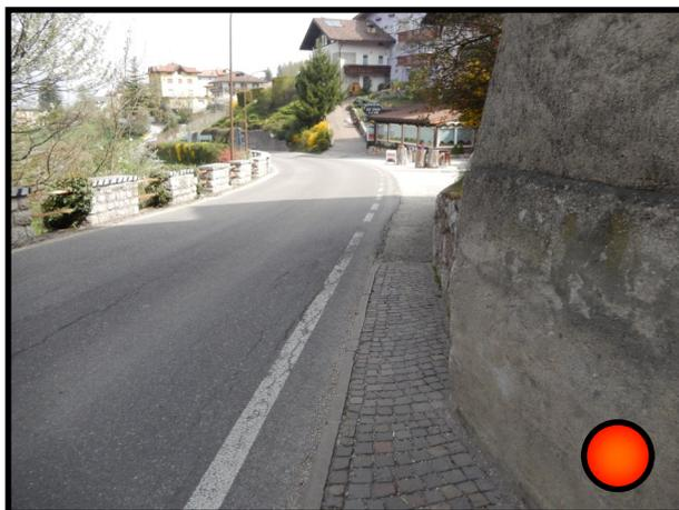
Il marciapiede di via Trento finisce senza una rampa e con uno scalino di 8 cm. In questo tratto si restringe molto (61 cm).
