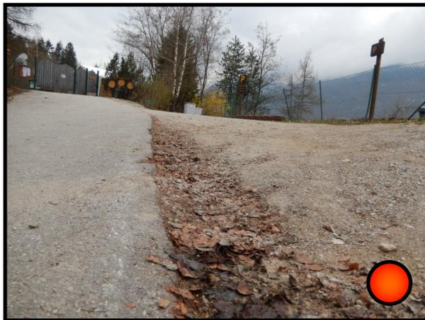
La situazione è davvero molto critica per un dislivello elevato tra la pavimentazione del parcheggio e l'asfalto della strada.
