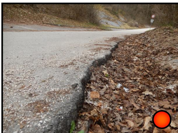
Qui possiamo notare come il bordo della strada sia irregolare. Inoltre la situazione si presenta molto pericolosa perché tra l'asfalto e il manto erboso c'è un dislivello di ben 15 cm.
