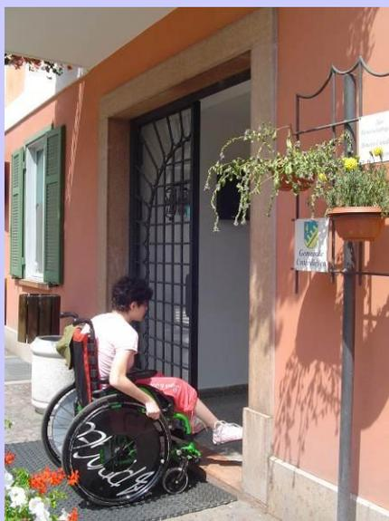
L'ingresso al Municipio non è facilmente accessibile, in quanto vi è la presenza di uno scalino, che nonostante sia basso impedisce il libero accesso a persone in carrozzina.
