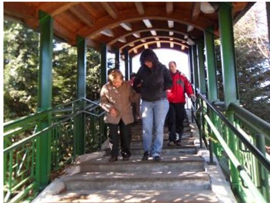
L'attraversamento pedonale che conduce alla rampa di accesso della stazione è ben segnalato ma è presente un marciapiede piuttosto alto che limita l'accesso a persone con difficoltà motorie. Il camminamento che conduce alla stazione non è sbarrierato in quanto sono presenti degli scalini che impediscono il libero passaggio. ■
