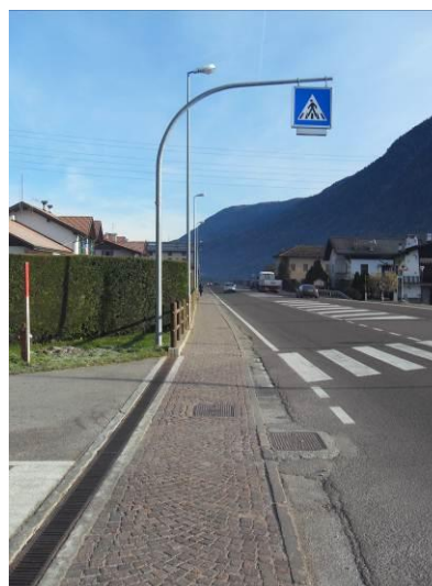
Tratto di marciapiede ed attraversamento pedonale nei pressi del centro commerciale
