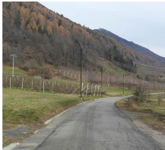
Via Novalina collegamento Monclassico - Croviana
