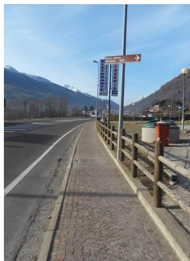
Tratto di marciapiede via Nazionale
