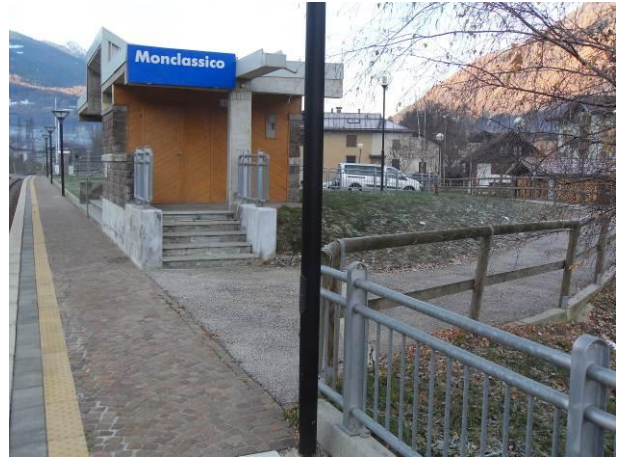
Marciapiede stazione ferroviaria
