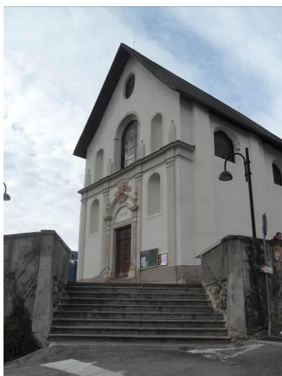
Scalinata di accesso chiesa di Monclassico
