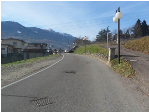
Tratto di Via Paolo Ravelli senza marciapiede né camminamento pedonale
