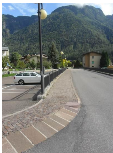
Particolare marciapiede Via Brescia
