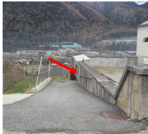
Rampa di accesso al cimitero
