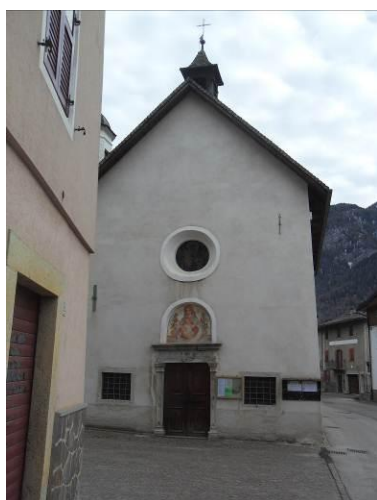
Ingresso principale chiesa di Presson
