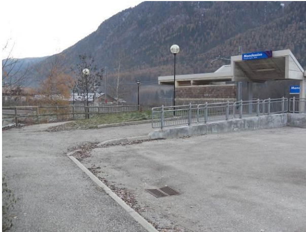
Marciapiede stazione ferroviaria
