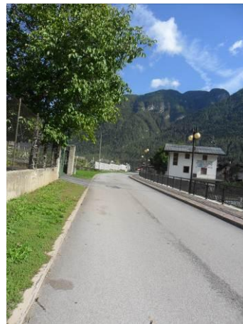
Tratto di Via Paolo Ravelli con marciapiede
